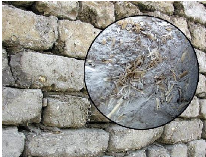
Figura 2.1. Muro com tijolo reforçado com palha no Egito (CÁNOVAS, 1988).
